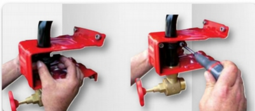
4/ Maintien en position de l'ensemble bobine et tube d'alimentation par un seul collier assemblé par deux vis
